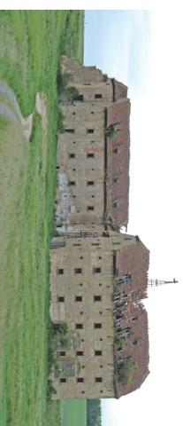
Die Bauausführung der noch stehenden Gebäude ist für einen landwirtschaftlichen Nutzbau technisch höchst komplex und eher der eines Palastes vergleichbar. Die Geschosse sind in allen Ebenen mit massiven Gewölben versehen, die ein hohes Maß an Feuersticherheit sowie eine erhebliche Belastbarkeit gewährleisten. Dies wird unterstützt durch eingelegte Spannanker aus Eisen, die unsichtbar im Gewölbe verlaufen.
